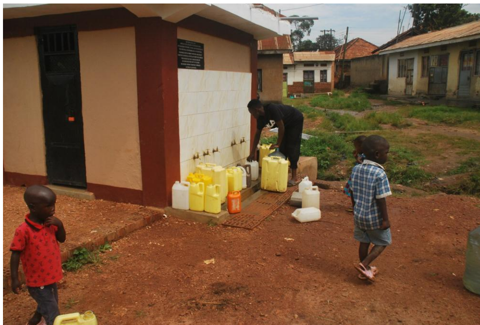
Het opgeleverde tappunt van de waterput in Muchanga, dagelijks in gebruik door de gemeenschap.
