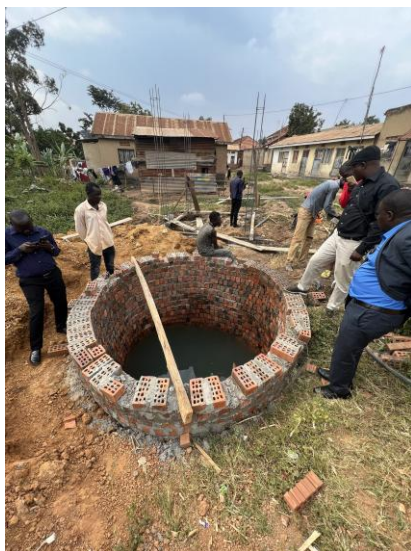
Zomer 2023: de ringmetselwerk-put tijdens de bouw en het eerste water voor de kinderen van Muchanga.
